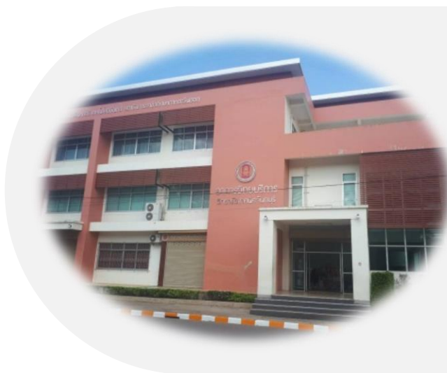
ชื่ออาคาร : อาคารเรียน 8 (อาคารวิทยบริการ)
